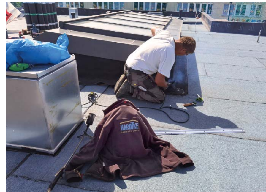
Das Dach der Erweiterung der Europaschule in Hagenow mit dem schönen Namen »Kietz Campus« wird derzeit gedeckt. Das Gebäude beherbergt bald einen Hort mit Multifunktionsraum.
