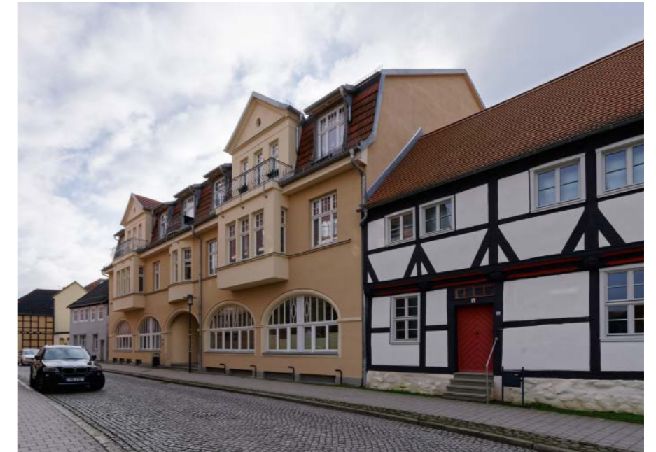
Das Dach des Wohn- und Geschäftshauses Karl-Marx-Straße 9/10 ist eine Hardtke-Arbeit, wie auch das Dach der rechts angrenzenden Nummer 8.
